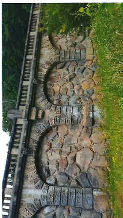
Stav vzdušného líce hráze a jeho spárování
