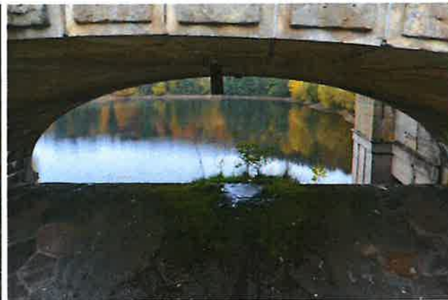
-Vyrůstající vegetace pod odvodňovačem v poli 5
