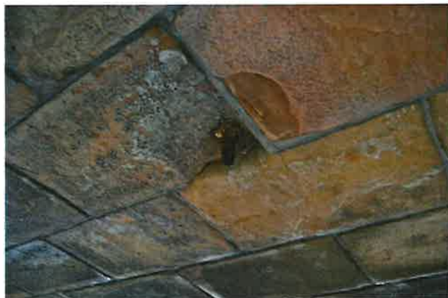
-Korodující ocelová trubička-odtržený kus kamene
