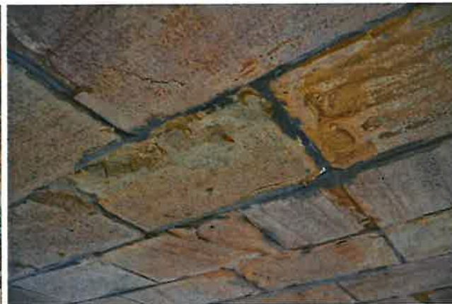
-Degradace povrchu kamenů na podhledu klenby
