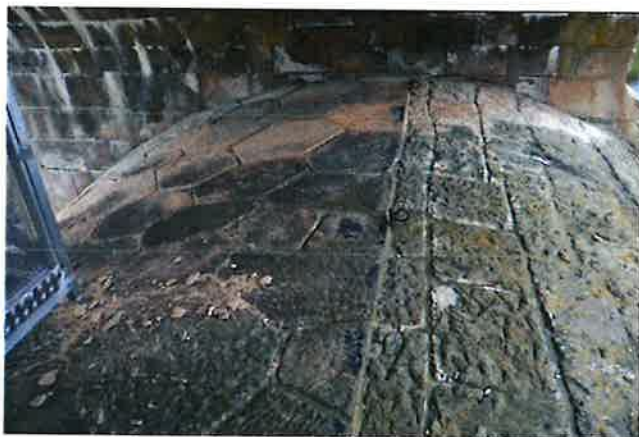
-Zbytky odpalých kusů pískovce na přelivu
