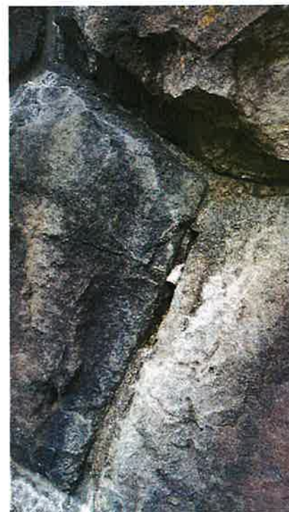
Stav vzdušného líce hráze a jeho spárování
