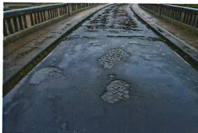
-Pohled na vozovku na mostě - žulové kostky přebaleny vrstvou AB
