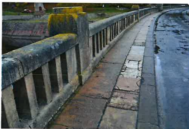
-Chodník vlevo s instalačním kanálem
