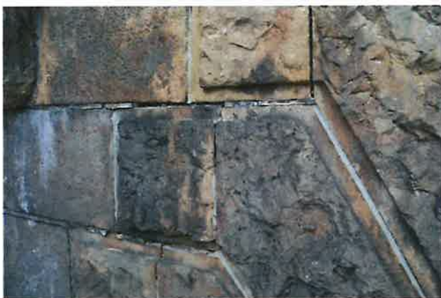
-Lokálně vypadané spárování
