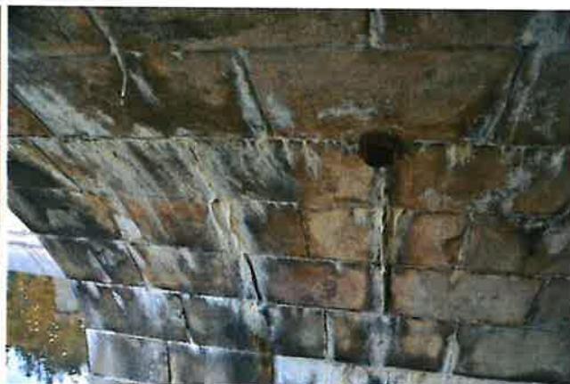
-Vyústění odvodnění
