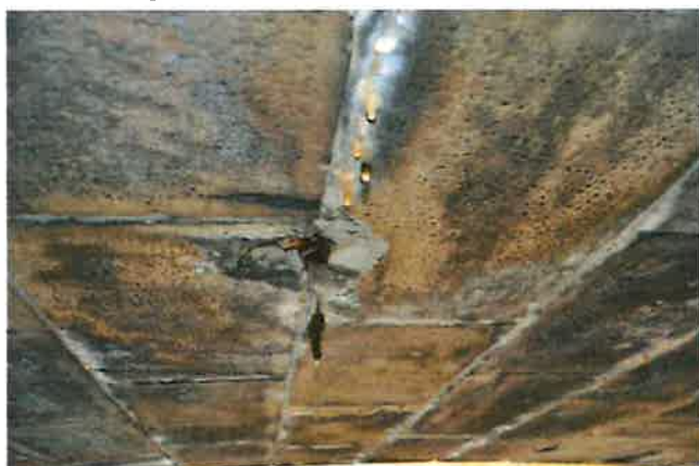
-Zatékání, výluhy
