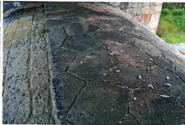
-Zbytky odpalých kusů pískovce na přelivu
