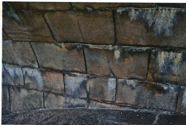
-Trhlina v kameni P2
