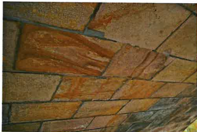
-Podhled klenby v poli1, lokálně vypadané spárování
