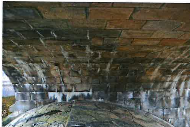
-P4 z pole 3, výluhy, inkrustace
