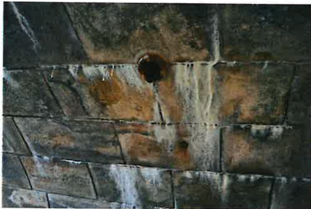
-Vyústění odvodňovací trubičky
