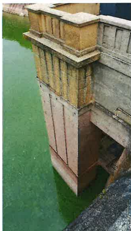
Levá návodní věž tabulového uzávěru
