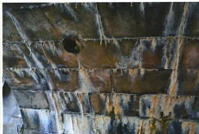
-Vyústění odvodňovací trubičky, inkrustace
