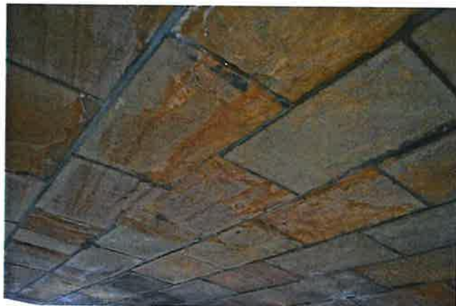
-Podhled klenby v poli 3, degradace povrchu kamenů
